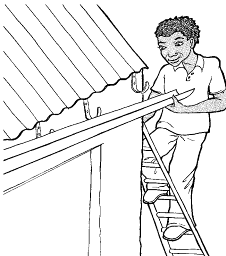
Figura 4: Montando um sistema de caleiras
